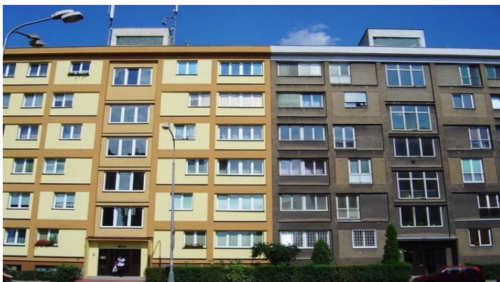
Obr. 5: Provedená revitalizace – DECPLAST, Brno
