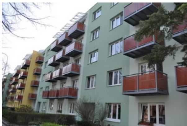
Obr. 4: Provedená revitalizace – PROFIPLAST, Kotěrova, Brno
