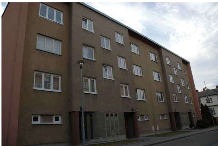
Obr. 2: Bytový dům Al. Skotáka 2, 4 Blansko
