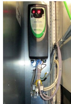
Obr. 32 - frekvenční měnič napájející motor vyhrnovacího šneku
