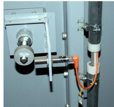
Obr. 27 - indukční snímač koncové polohy dráhy vozíků
