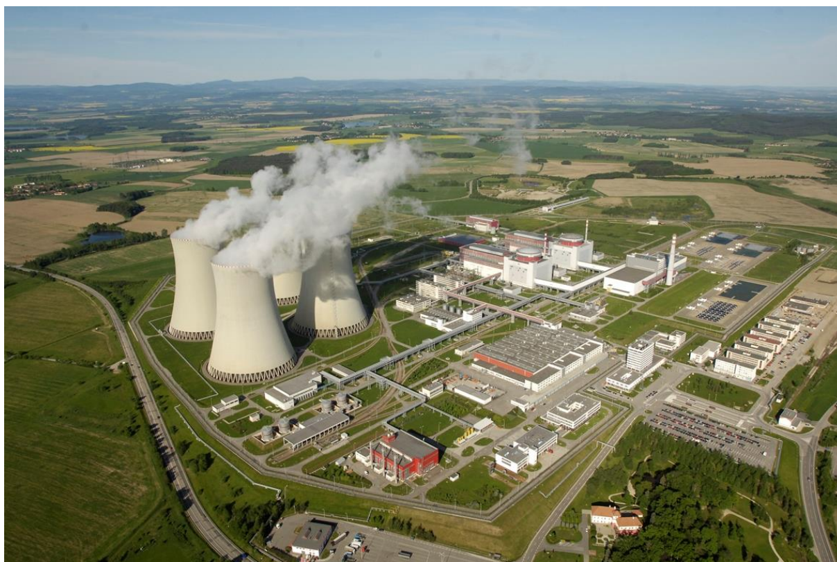
Obrázek 5 Letecká fotografie Jaderné elektrárny Temelín [3]
