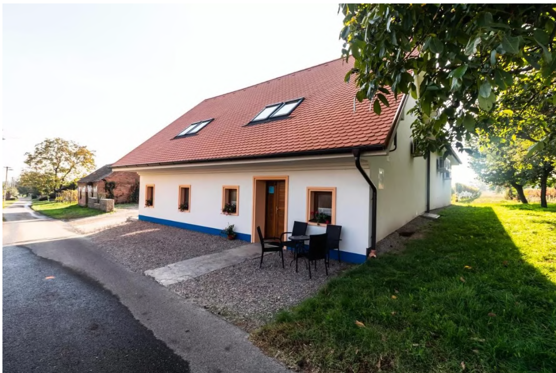
Obr. 7: Nová budova sklepu (Zdroj: vinařství Výmola 2018)
