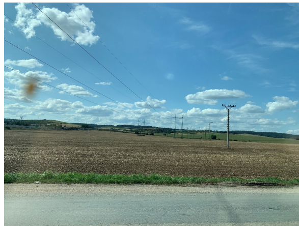
Obrázek 3 – Energetická infrastruktura v krajině (zdroj: archiv autora)
