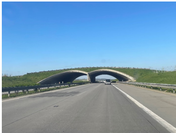
Obrázek 2 – Příklad ekoduktu, který nemá dostatečnou šířku a nevytváří vhodné bezpečné prostředí pro živočichy (zdroj: archiv autora)
