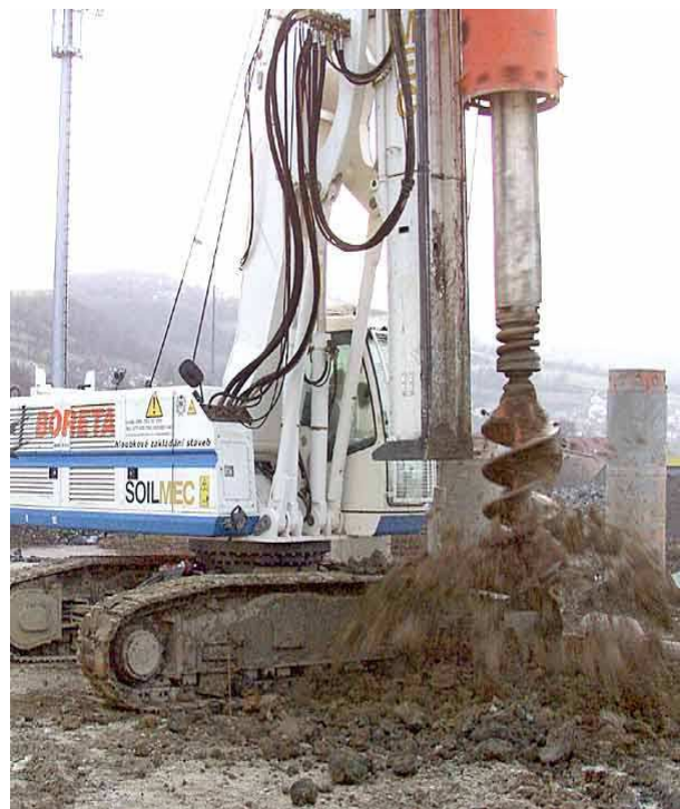
Obr.3.3: Vrtání piloty rotační technologií [17]
