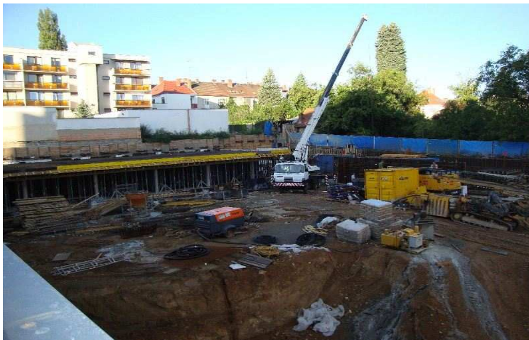
Obr.5.2: Pohled na stavební jámu z ulice Veverí [21]
