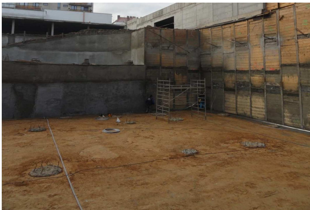
Obr.5.3: Pohled na dno stavební jámy. Jednotlivé piloty jsou již zabetonovány a připraveny na další fázi výstavby [22]
