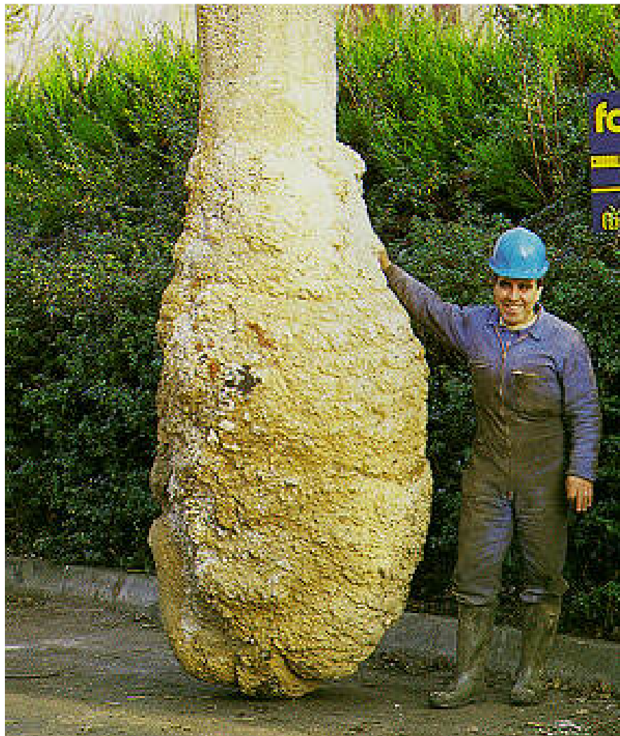
Obr.3.10: Pohled na „cibuli“ piloty Franki [13]
