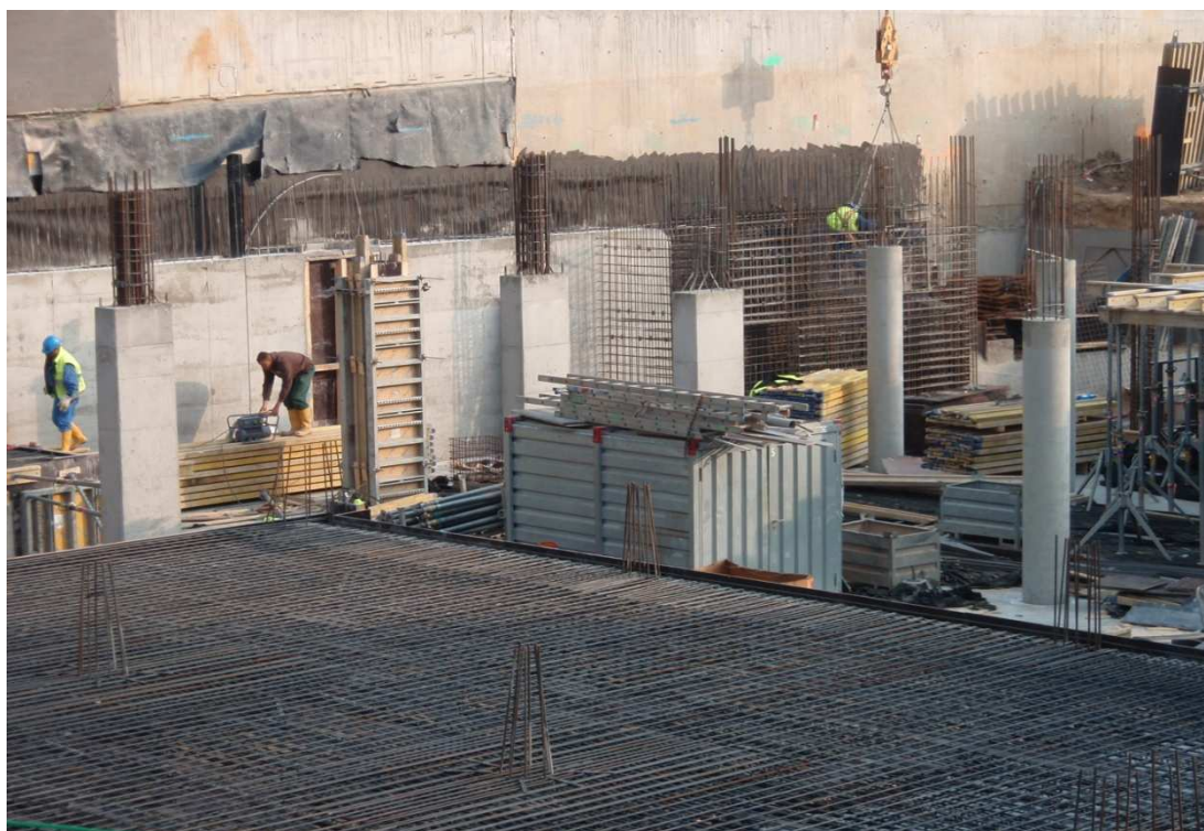
Obr.5.5: Stavba ve fázi výstavby skeletu
