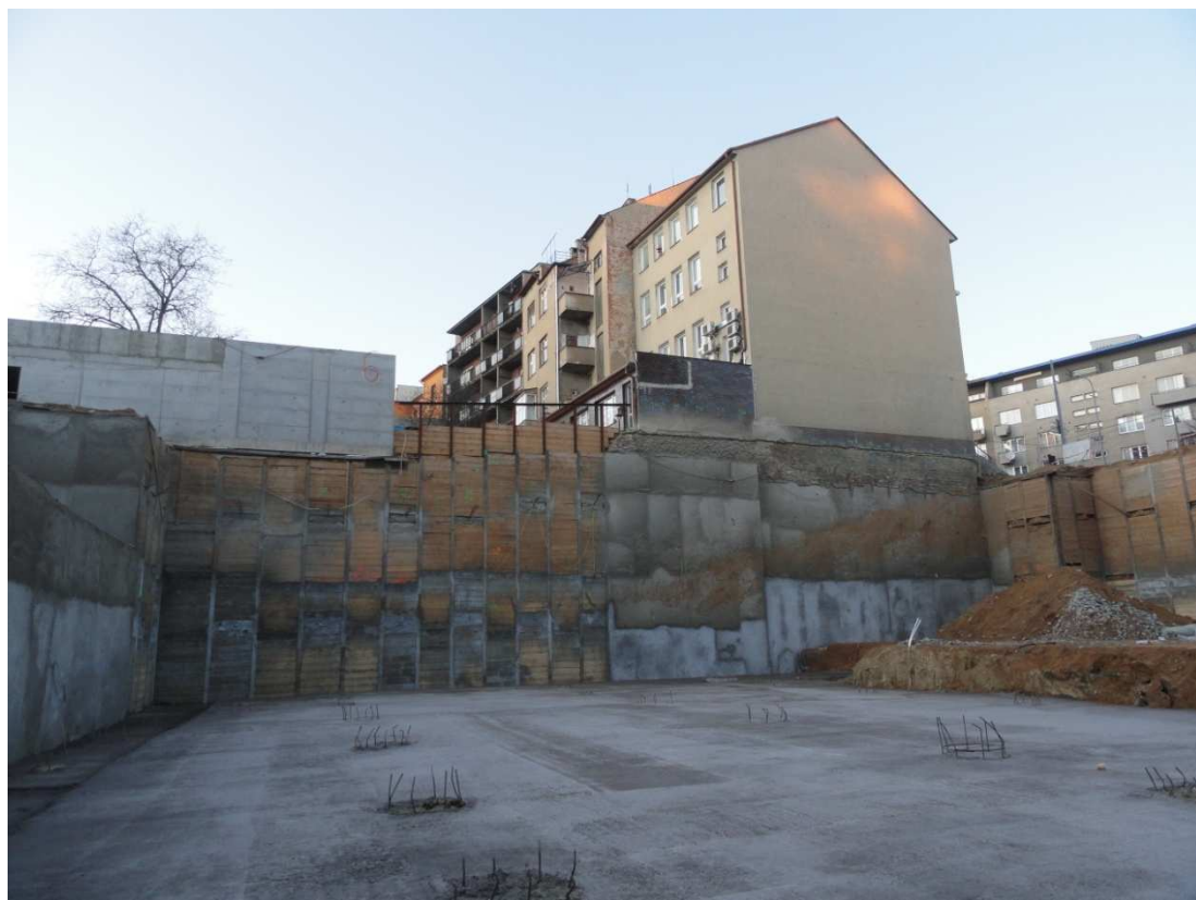
Obr.5.4: Pohled na zhotovenou základovou desku. Rozmístění pilot je zřejmé dle vyčnívající výztuže [22]
