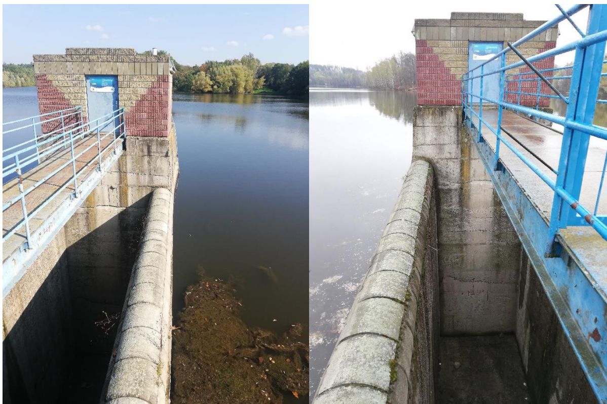
Obrázek 8: Detail na hranu bezpečnostního přelivu
