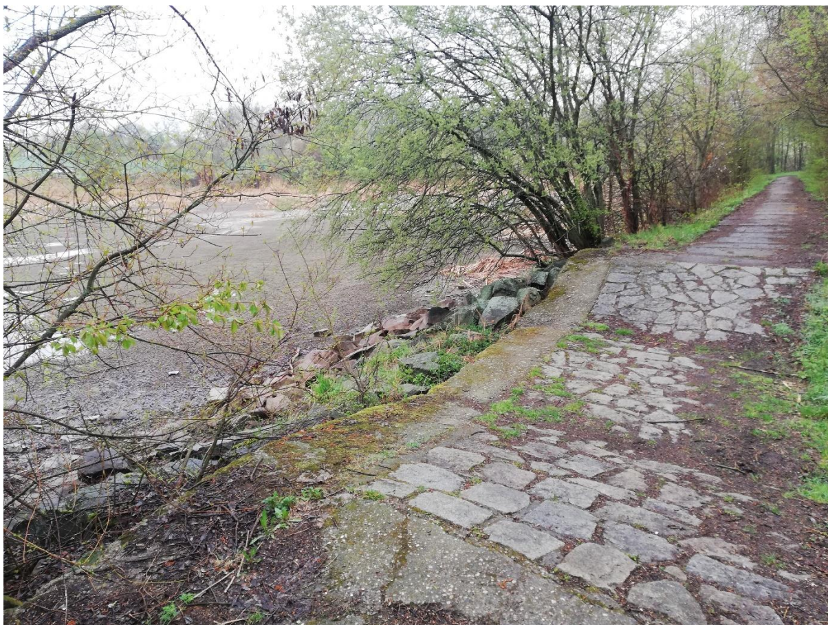
Obrázek 12: Bezpečnostní přeliv na břehu rybníka
