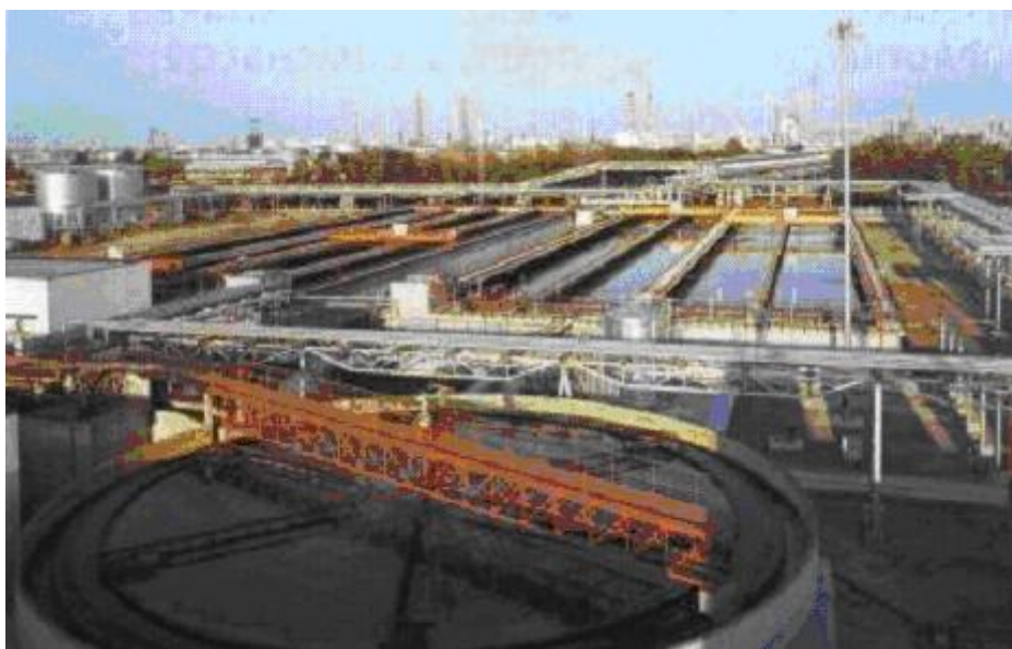
Obr. č. 17 – MCHB ČOV v objektu Podniku A
