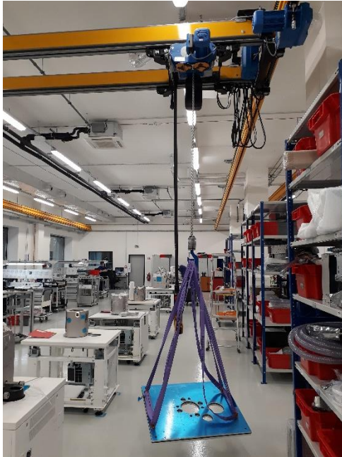
Obrázek 6 Příklad využití jeřábu (Zdroj: Vlastní zpracování)
