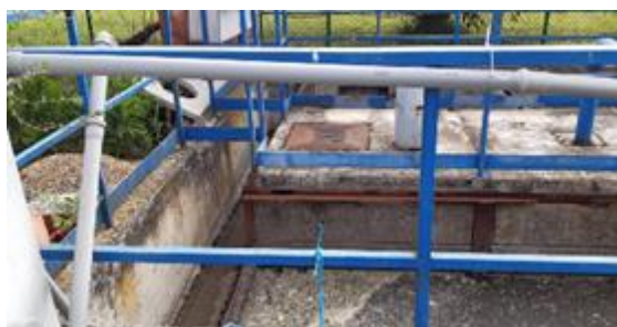
Obr. 12 – pohled na usazovací nádrž
