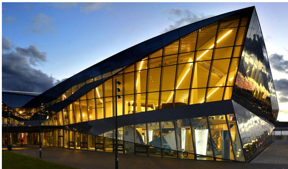
Obr. 17. „Budova budoucnosti“ The Crystal v Londýně [34]
