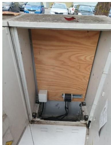
Obrázek 2-7 Volná skříň pro přidání zařízení k dálkovému ovládní
