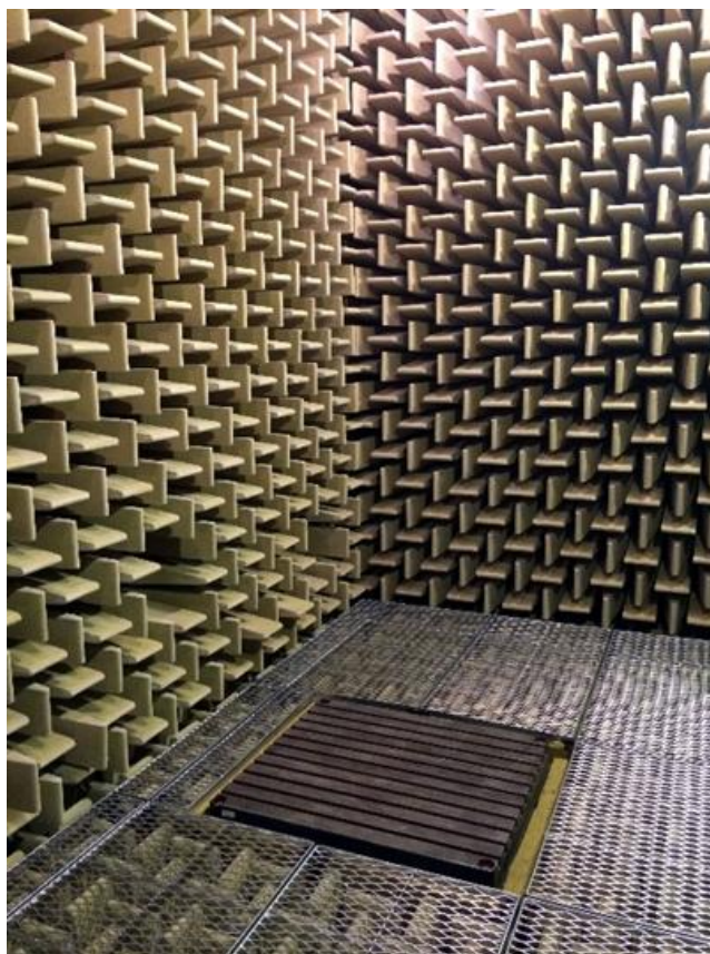
Obr. 10 Bezdozvuková komora na FSI VUT v Brně
