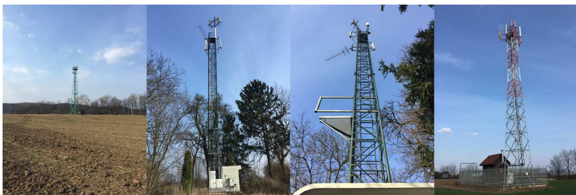
Obr. 3.13: Telefonní věže BTS.
