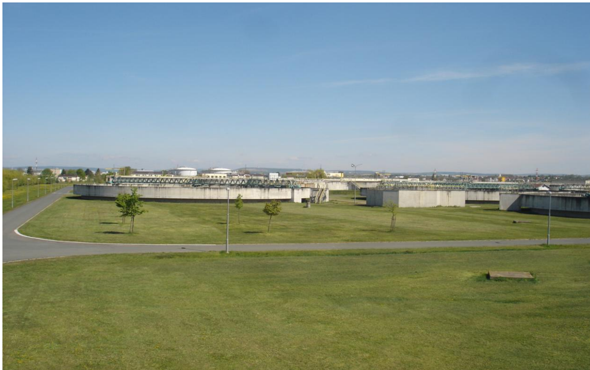
Obrázek č. 33: Čistírna odpadních vod Brno-Modřice
