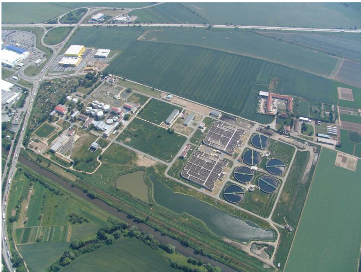
Obrázek č. 34: Letecký snímek čistírny odpadních vod Brno-Modřice
