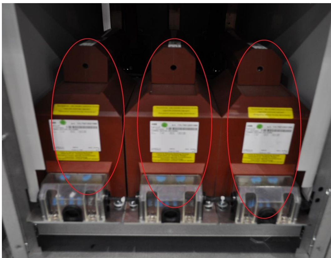
Obr. 25 Meracie transformátory napätia s vyznačenými možnými miestami vzniku čiastkových výbojov
