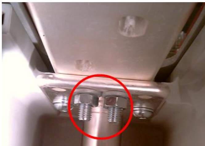
Obr. 54 Kritická dĺžka šróbov na uchytení horného držiaka vypínača ABB Vmax
