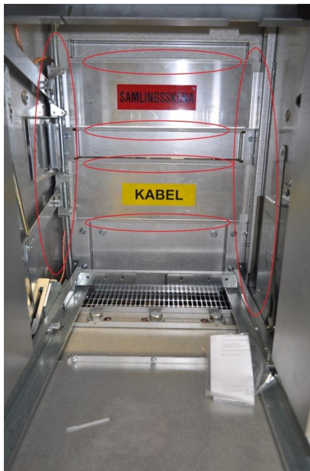
Obr. 31 Oddiel vypínača s vyznačenými možnými miestami vzniku čiastkových výbojov
