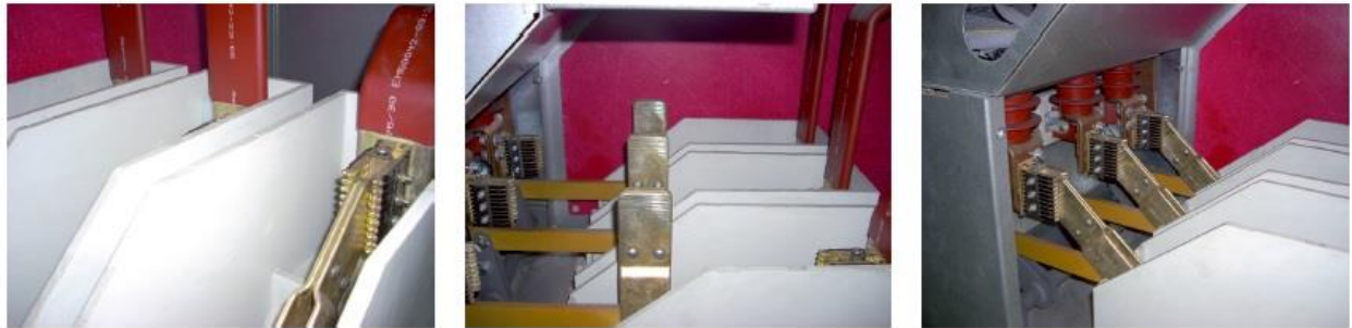
Obr. 5 Jednotlivé polohy trojpolohového odpojovača v rozvádzači ABB UniGear 500R
