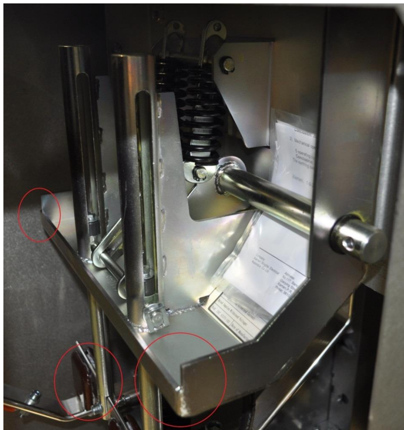
Obr. 36 Uzemňovač s vyznačenými možnými miestami vzniku čiastkových výbojov
