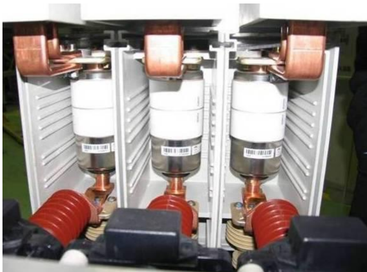
Obr. 6 Vákuový vypínač ABB Vmax
