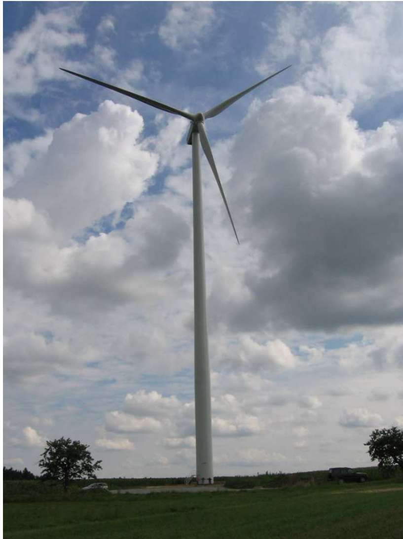
Obr.5 Jedna z větrných elektráren u obce Pavlov na Vysočině
