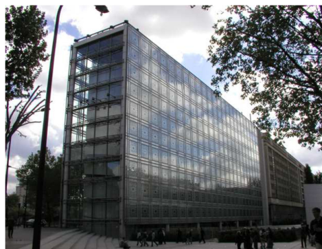
Obr.10. Arabský institut, Paříž – pohled na venkovní fasádu
