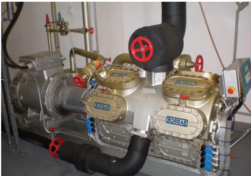
Obrázek 8 Pístový kompresor dvoustupňový [27]
