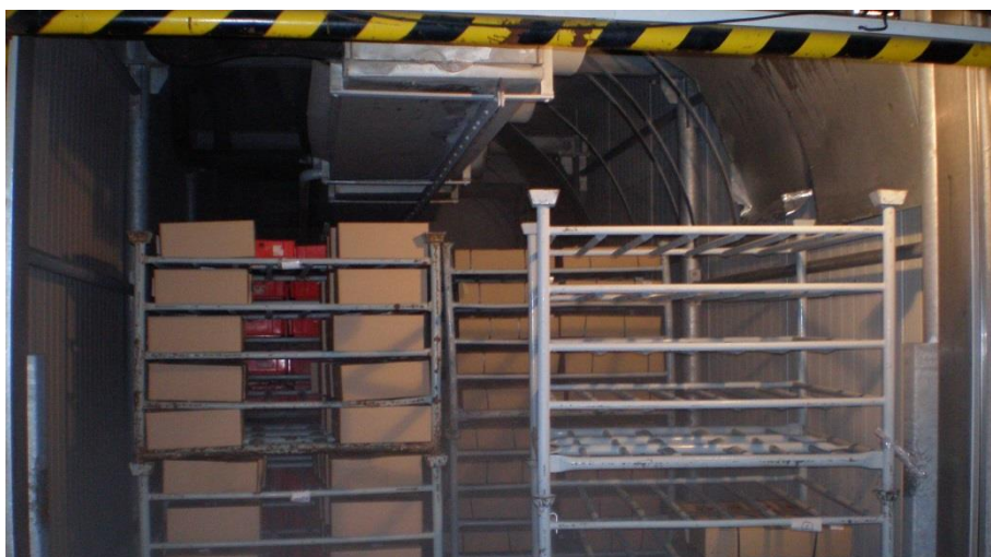
Obrázek 27 Přímé chlazení zboží [27]
