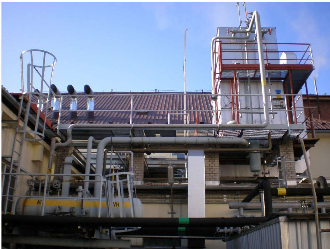
Obr. 18 Sběrač kapalného chladiva pod odpařovacím kondenzátorem [27]
