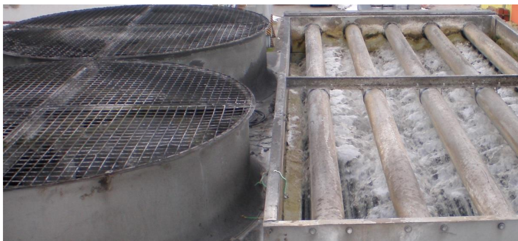
Obr. 17 Odpařovací kondenzátor při provozu [27]
