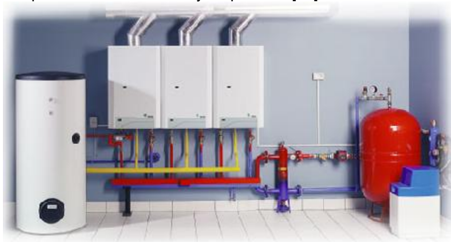
Obr.7 Kaskádová kotelna [15]
