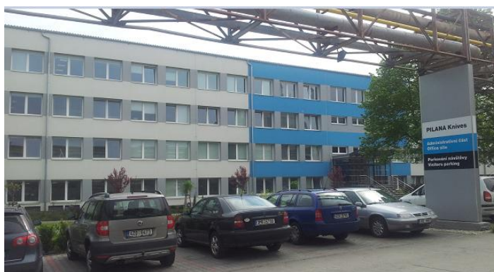
Obr. 2.2 Pilana Knives s.r.o., čelní pohled.
