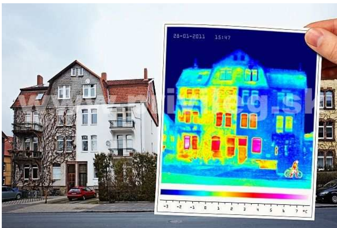
Obr. 24 Termogram zdiva rodinného domu [24]
