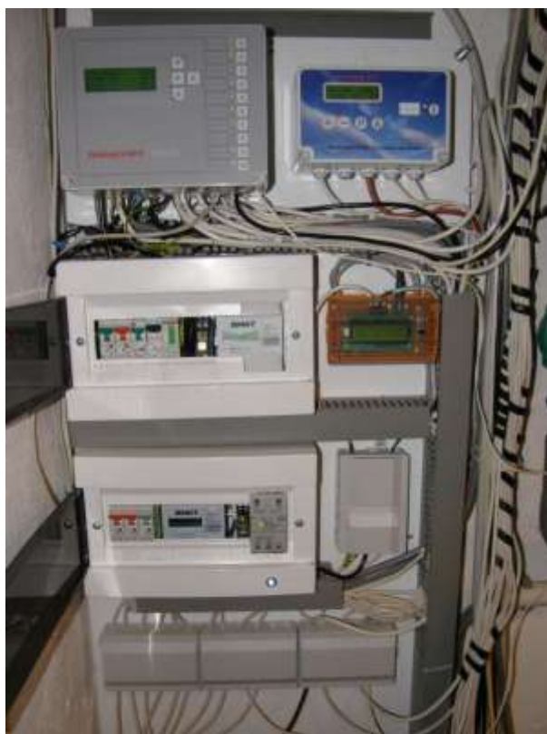
Obrázek 23: Řídící jednotka a elektroměr HXE12 AS
