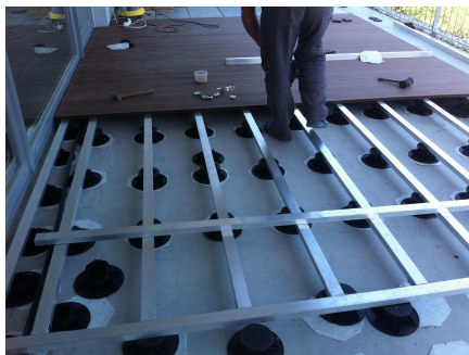
Obr.23. Umiestnenie rektifikačných terčov
