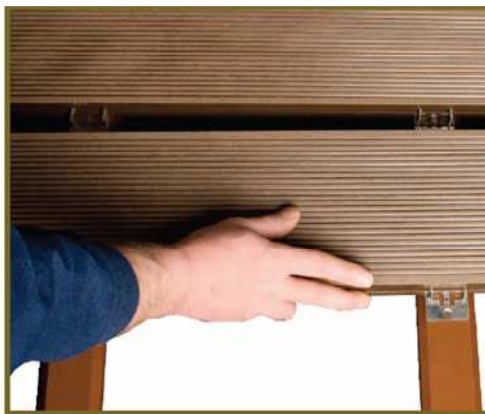
Obr.25. Priloženie nasledujúcej dosky
