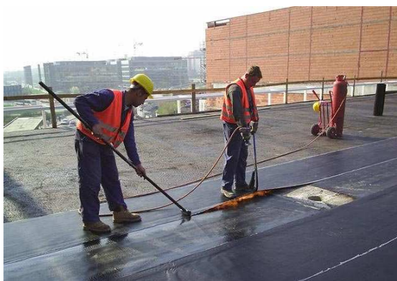
Obr.12. Natavenie asfaltových pásov
