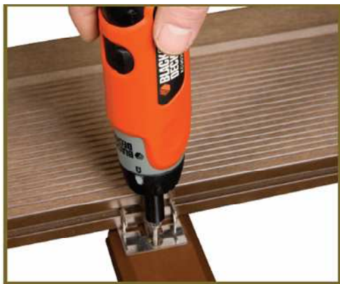
Obr.24. Detail upevnenia klipu o podkladný hranol
