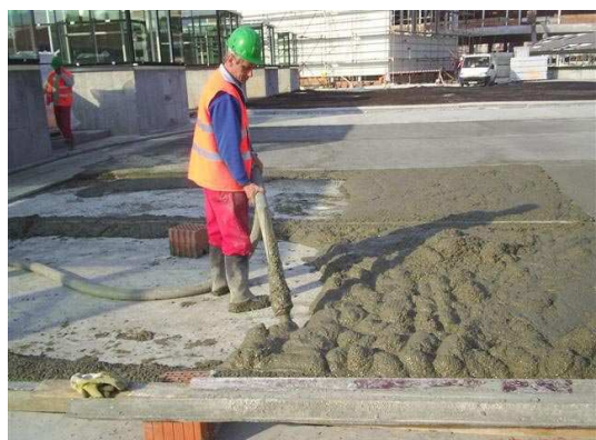
Obr.6. Ukladanie PsB zmesi
