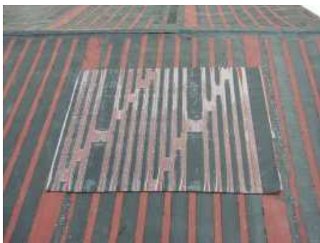
Obr.13. Therm pruhy parozábrany
