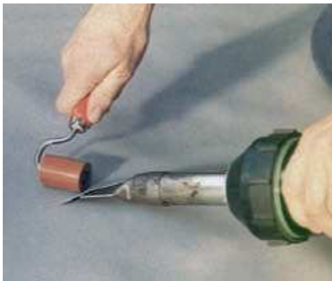
Obr.16. Zváranie so zavalčekovaním
