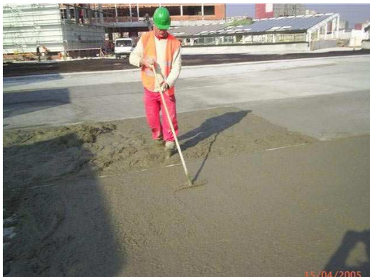
Obr.5. Úprava povrchu hladítkom
