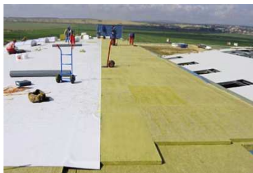
Obr.14. Položenie tepelnej izolácie
