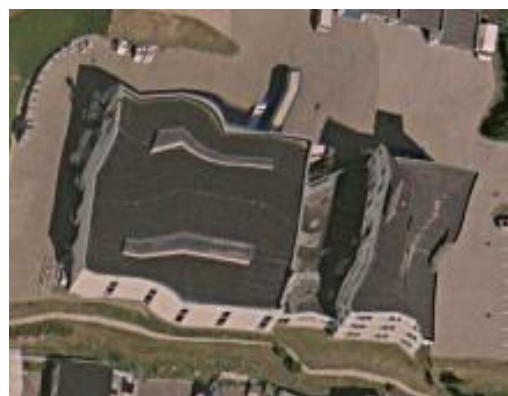
Obr. 57: Deformace na budovách
