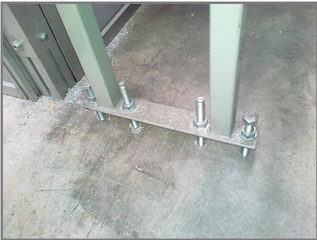
Obr. 2-4 Kotvení nohy původního dopravníku
