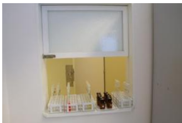
Příloha č. 3 Dvířka propojující přípravnu vzorků a laboratoř na hodnocení
