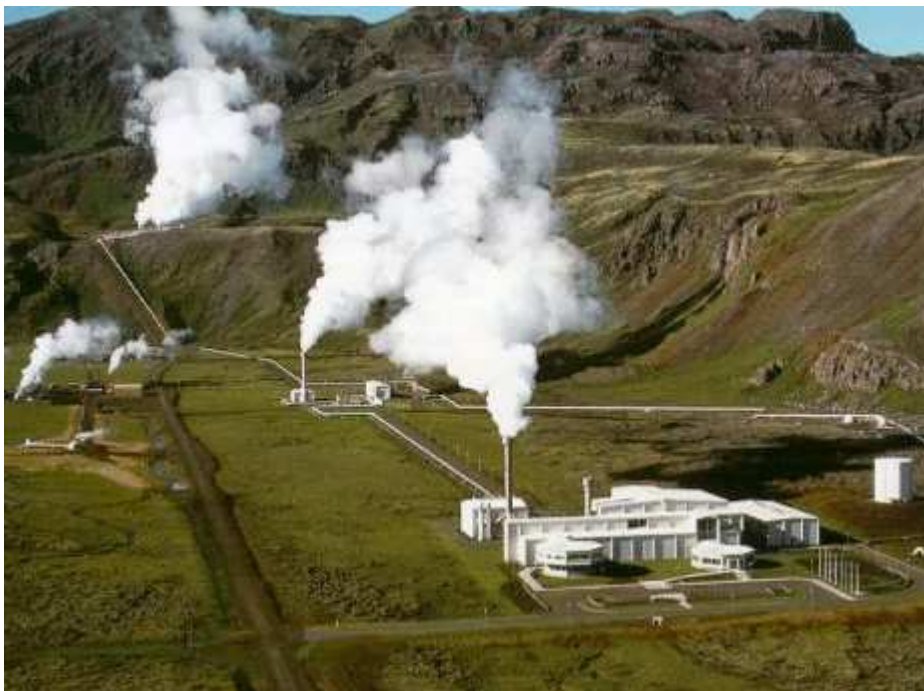
Obr. 17: Geotermální elektrárna v USA [38]
