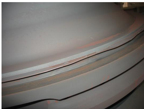
Obrázek 41 Chybějící těsnící plech na ucpávce vyrovnávacího pístu [1]
