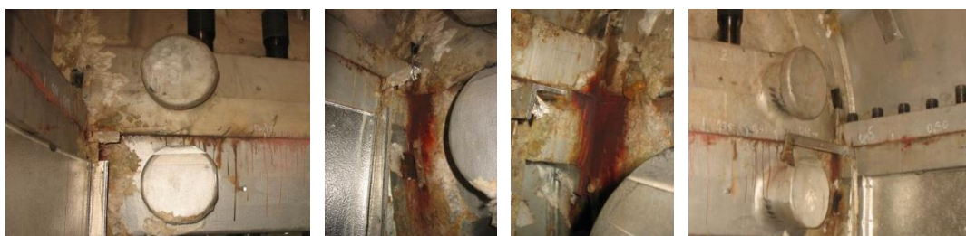
Obrázek 19 Znárodněný únik páry v oblasti dělicí roviny a křížového spoje [1]
