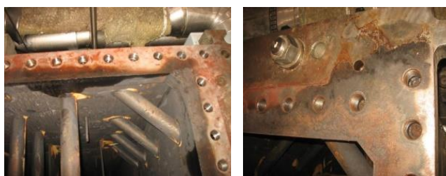
Obrázek 24 Stav dělicí roviny výstupního hrdla po demontáži [1]
