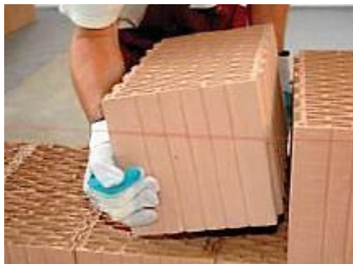
Obr. 4-15: Kladení cihel zasunutím do drážek
