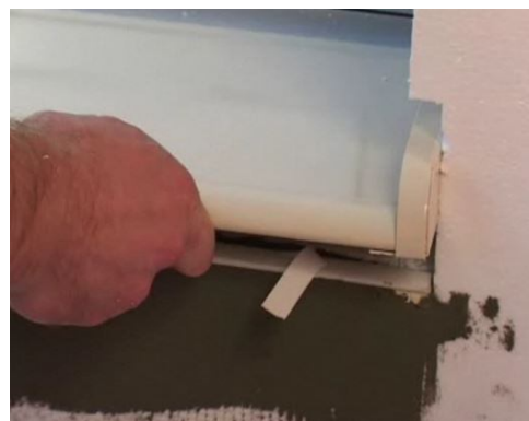
Obr. 11.1-42: Nasunutí parapetu na profil s částečně odtrženou páskou
