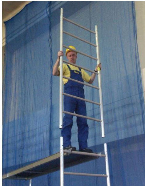
Obr. 11.1-6: Nasunutí svislého rámu
