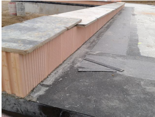
Obr. 4-4: Ochrana zdiva proti pronikání vody do komůrek
