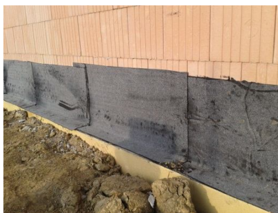
Obr. 11.1-24: Zpětný spoj
