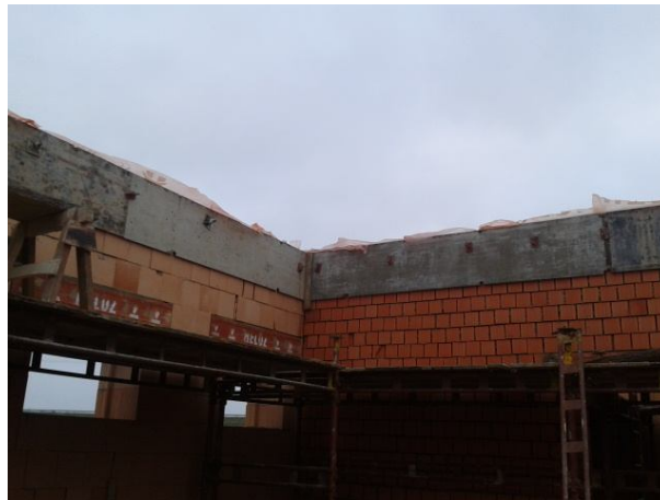
Obr. 4-26: Bednění pozedních věnců
