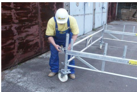
Obr. 11.1-3: Spojení pojízdných ocelových rámu
