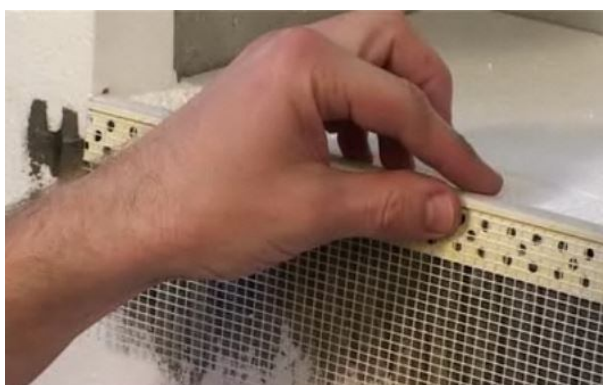
Obr. 11.1-41: Osazení parapetního profilu do lepicího tmele
