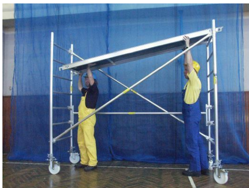
Obr. 11.1-8: Zavěšení montážní podlahy
