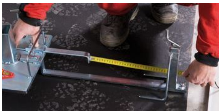
Obr. 4-7: Nastavení požadované šířky maltového lože
