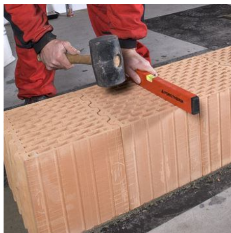
Obr. 4-11: Urovnání cihel první vrstvy v příčném směru
