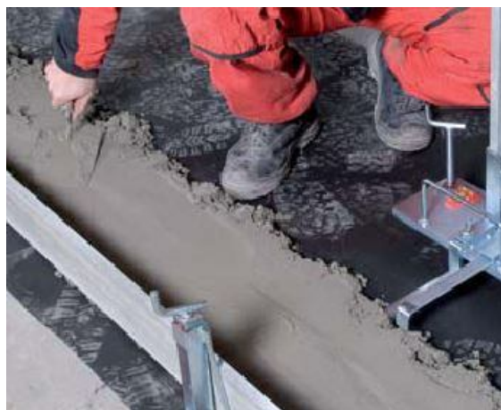
Obr. 4-8: Nanášení maltového lože
