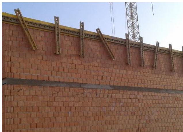
Obr. 6-6: Provedení bednění obručových věnců na reálné stavbě v Brně
