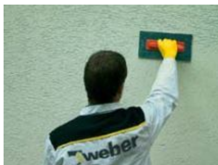
Obr. 11.1-44: Vytvoření struktury omítky
