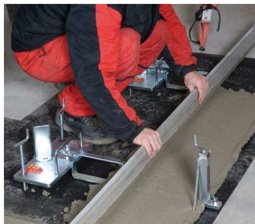
Obr. 4-9: Urovnání maltového lože podle vodicích lišt
