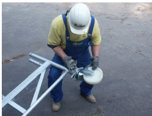
Obr. 11.1-1: Montáž základového nosníku s pojezdovými koly
