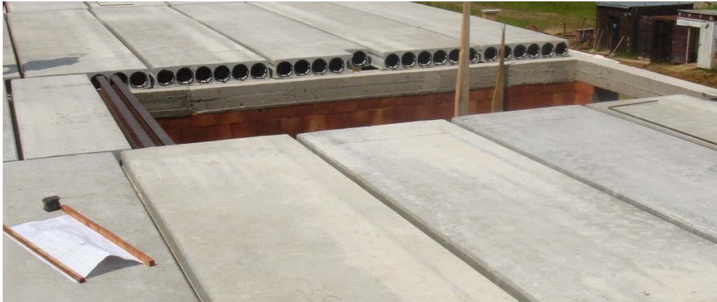
Obr. 6-4: Osazení ocelových nosníků v prostoru schodiště
