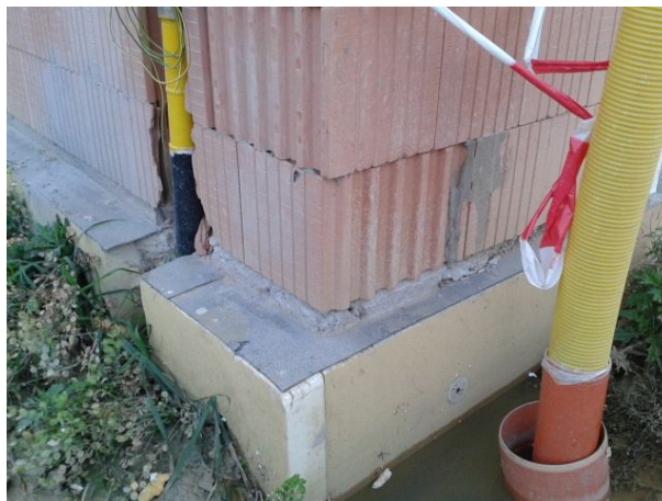
Obr. 4-5: Hydroizolace pod první vrstvu zdiva
