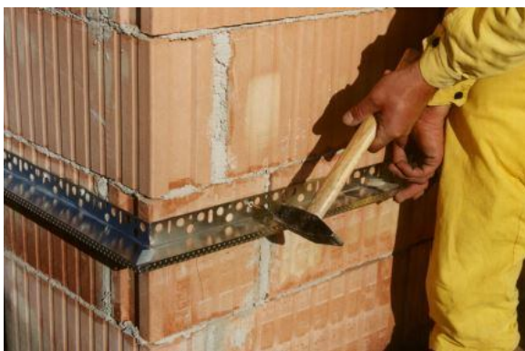
Obr. 11.1-27: Připevnění základací lišty zatloukáací hmoždinkou
