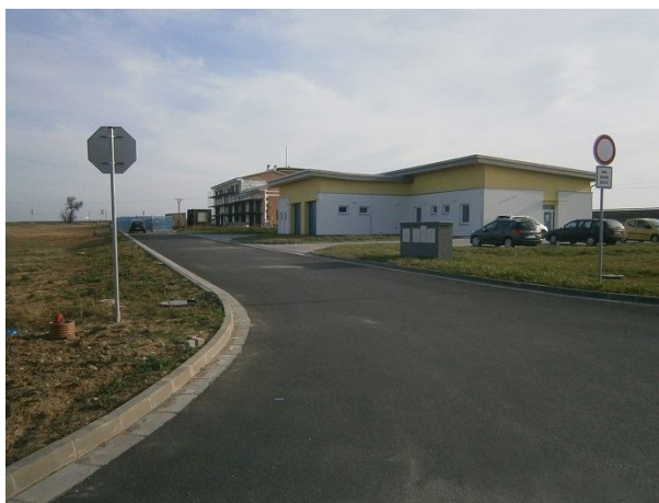
Obr. 2-12: Staveniště PS a budova ZS
