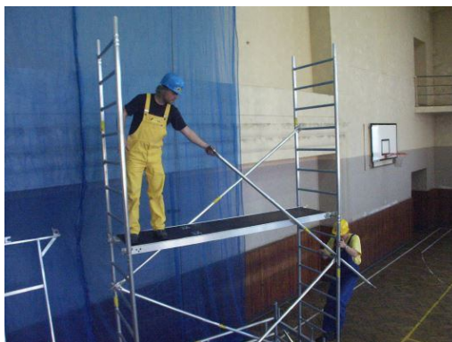
Obr. 11.1-7: Ztužení diagonálami
