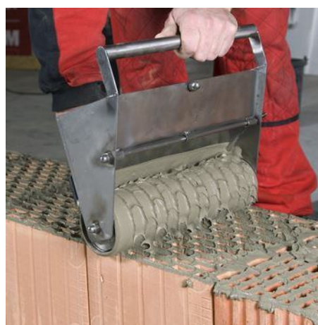
Obr. 4-14: Nanášení malty na ložnou plochu cihel
