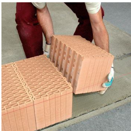
Obr. 4-10: Kladení první vrstvy cihel
