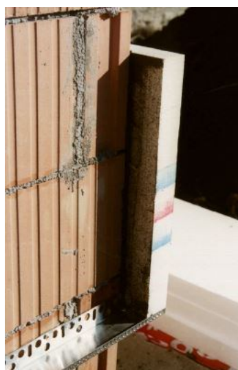
Obr. 11.1-31: Čistý spoj
