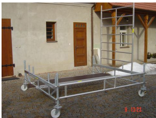
Obr. 11.1-4: Nasazení svislého rámu
