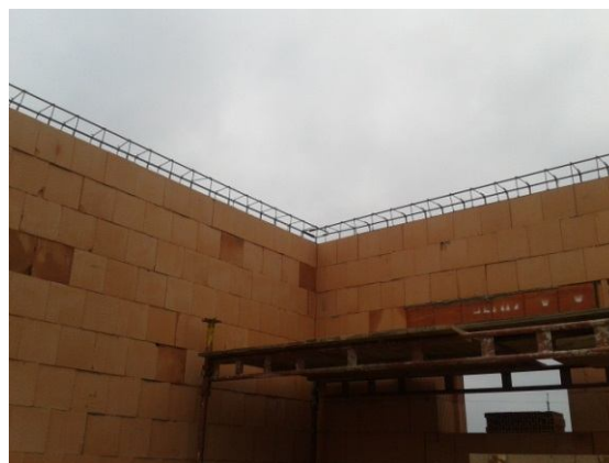
Obr. 4-24: Uložení armokošů na stěnu
