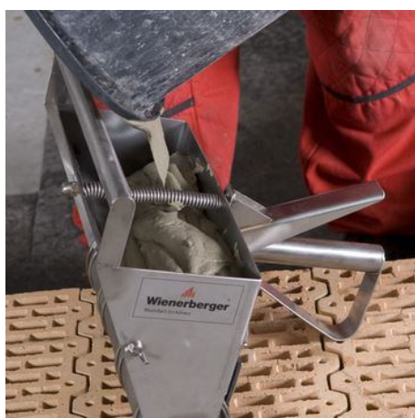
Obr. 4-13: Dávkování malty do zásobníku nanášecího válce
