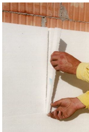
Obr. 11.1-32: Vyplnění mezery klínem z tepelné izolace
