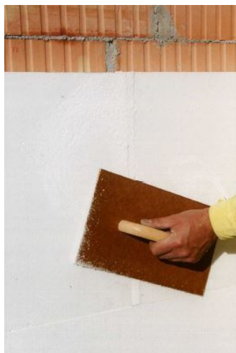
Obr. 11.1-36: Přebroušení povrchu izolantu
