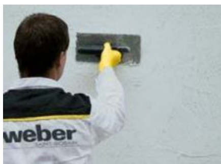
Obr. 11.1-43: Nanesení omítky na podklad
