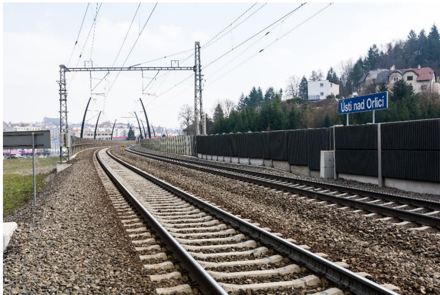
Obr. č. 17 – Pohled od výhybek na mostní estakádu
