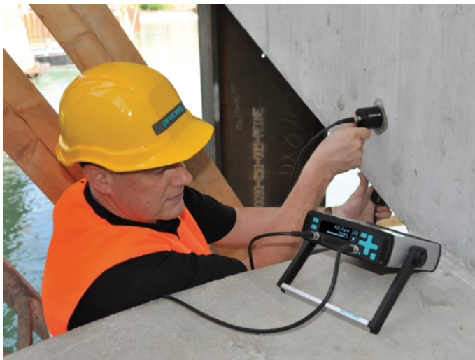
Obrázek 3.4: Rychlost průchodu ultrazvuku v terénu, měřená na hraně konstrukce. Převzato z [17].
