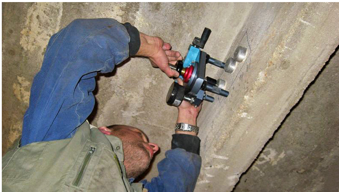
Obrázek 3.6: Provádění odtrhové zkoušky při diagnostice železobetonového žebra. Převzato z [20].
