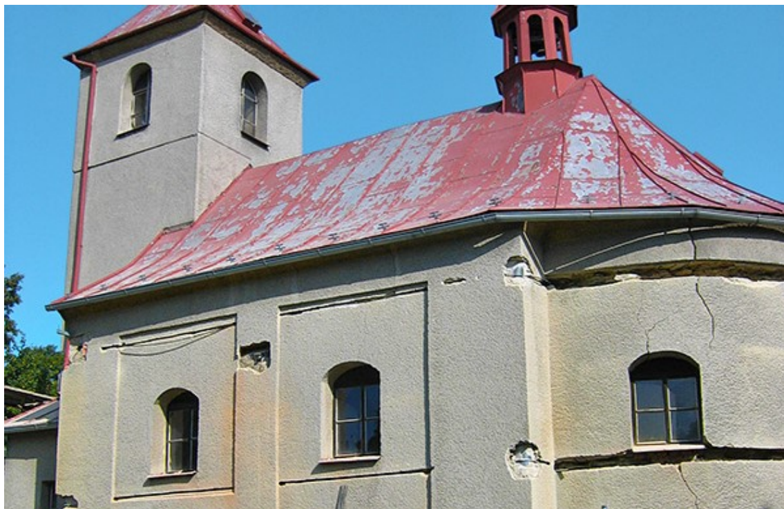
Obrázek 3.9: Ukázka předpínání kostela lany monostrand ve dvou úrovních. Převzato z [32].
