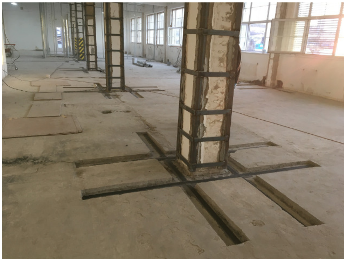
Obrázek 3.10: Ukázka sloupu zesíleného bandáží pomocí ocelových pásků a úhelníků. Převzato z [33].
