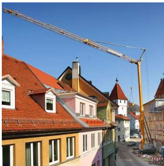
Obrázok 36 Rýchlo staviteľný vežový žeriav Liebherr 22 HM [7]
