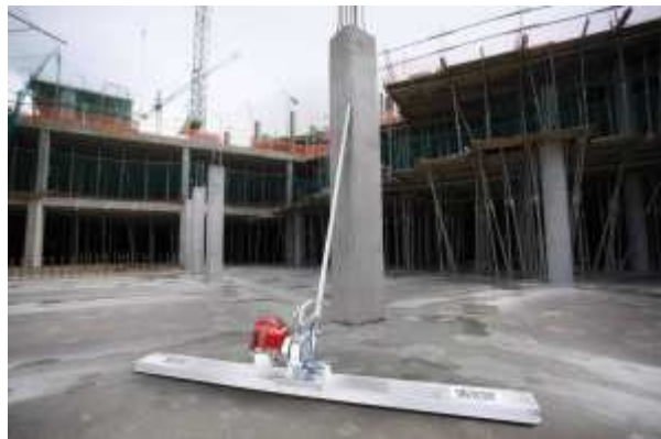
Obrázok 47 Plávajúca vibračná lišta RVH200 - 3m [16]
