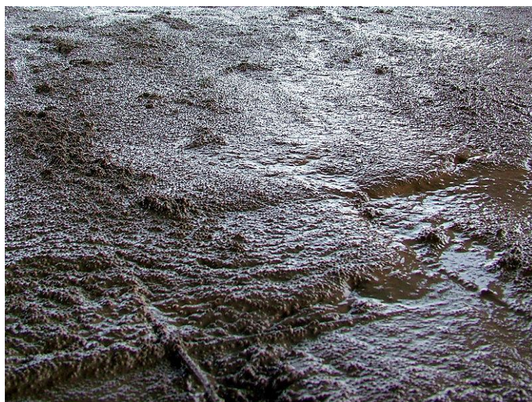
Obr. č. 9 Aplikování polystyrenbetonové podlahy
