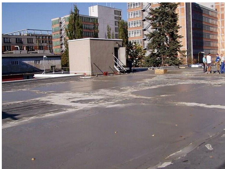
Obr. č. 10 Plochá střecha z polystyrenbetonu
