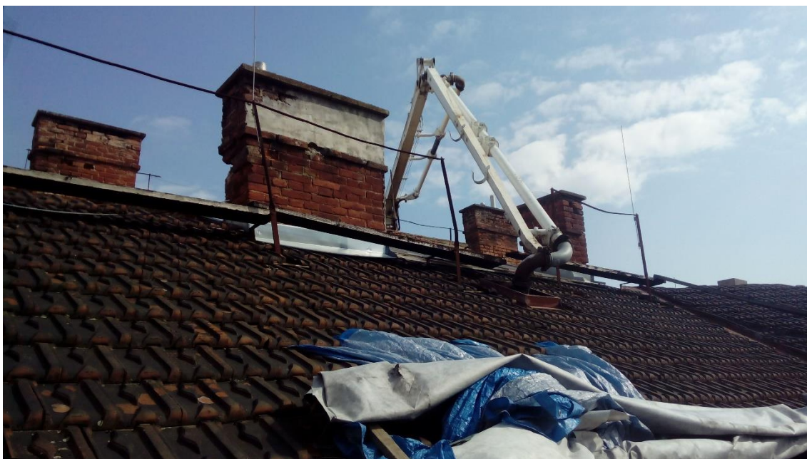
Obr. 26 Čerpání betonu skrze otvor ve střešním plášti
