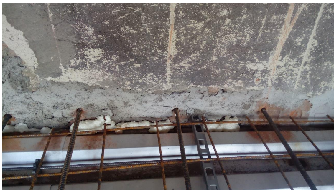
Obr. 25 Kotvení výztuže do zdiva
