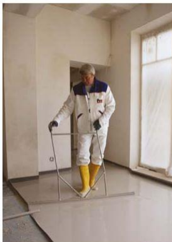
Obr. 29 Čerění potěru pomocí latě [14]
