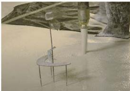
Obr. 28 Lití potěru a nivelační trojnožka [14]
