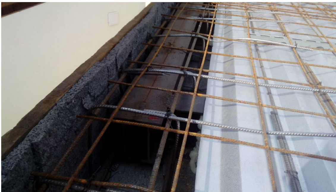
Obr. 24 Ocelový nosník přes překlad
