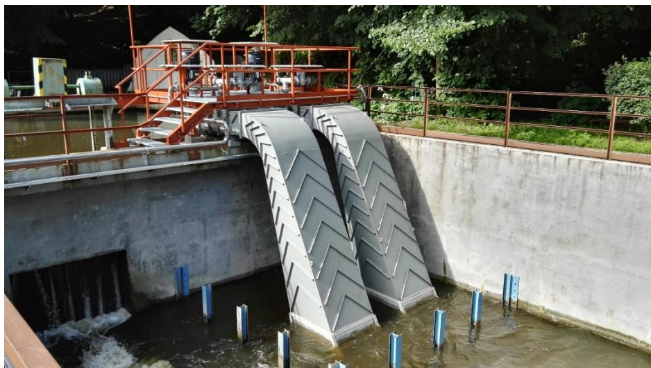
Obr. 4.1 Pohled na dvojici savek násoskových Vírových turbín MVE Želina
