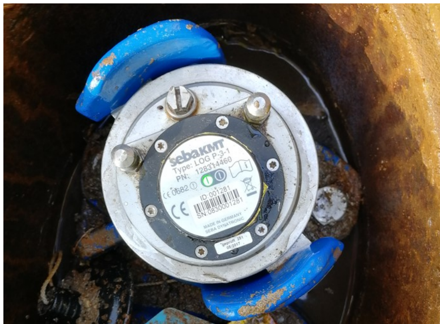
Obr. 28: Osazené tlakové čidlo Sebalog P3
