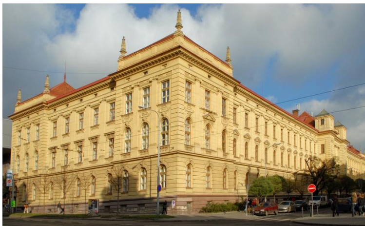
Obr. 1: Budova SPŠ a VOŠT na Sokolské (Zdroj 5 )
