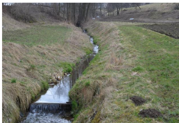
Obr. 3.30: Prosekaný příčný profil úseku č.5 [15]
