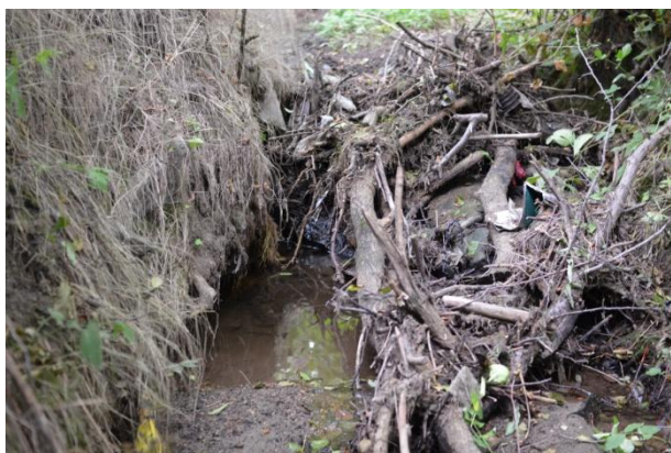
Obr. 3.17: Podemletí břehu, zanesení koryta [15]
