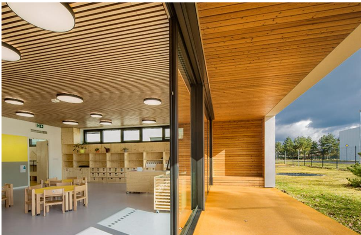
Obrázek 18 MŠ Doubek – stavba roku 2021, zdroj [12]
