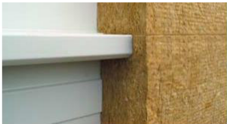
Obr. 35 – Izolační deska Airrock ND v nosné kazetě
