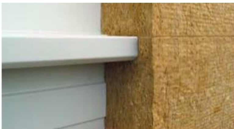
Obr. 35 – Izolační deska Airrock ND v nosné kazetě
