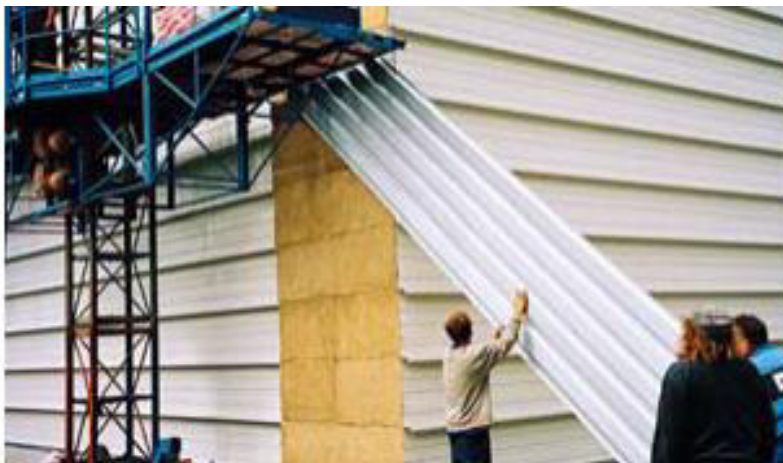
Obr. 43 – Přesun desky na fasádu
