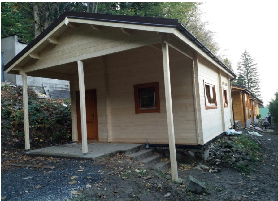
Obrázek 6-1- Čelní pohled na srubovou chatu [vlastní zpracování]
