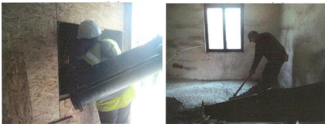
Obr. 50: Ukládka betonu s popílkem po procesu SNCR
