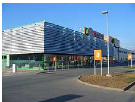
Obrázek 4 Rekonstrukce pekárny Globus Pardubice, zdroj: www.cht-pce.cz
