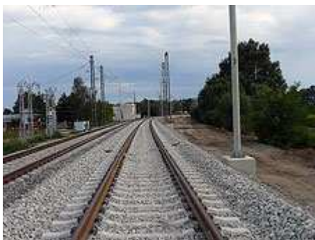
Obrázek 2 Rekonstrukce želez. svršku Břeclav, zdroj: www.cht-pce.cz
