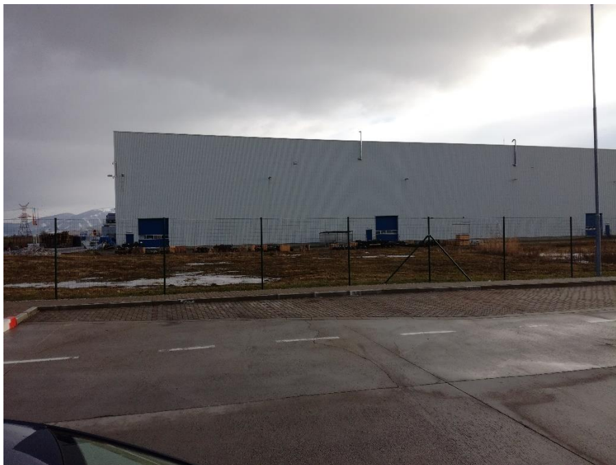
Obrázok 43: Priestor zariadenia staveniska
