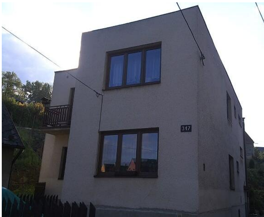
Obrázek 13: Rodinný dům č.4 - po rekonstrukci
