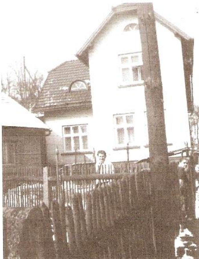
Obrázek 11: Rodinný dům č. 4 - před rekonstrukcí
