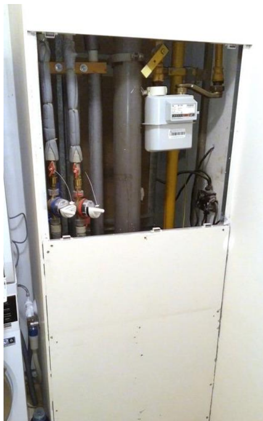
Obrázek 4. Instalační šachta – provedení [8]
