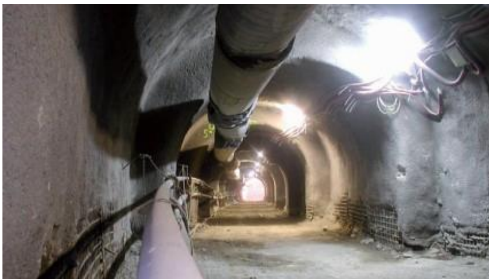
Obrázek 14. Instalační kolektor [11]
