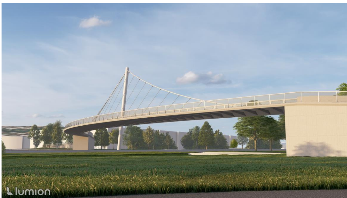
Obr. 34 Vizualizace: Pohled na dokončenou konstrukci
