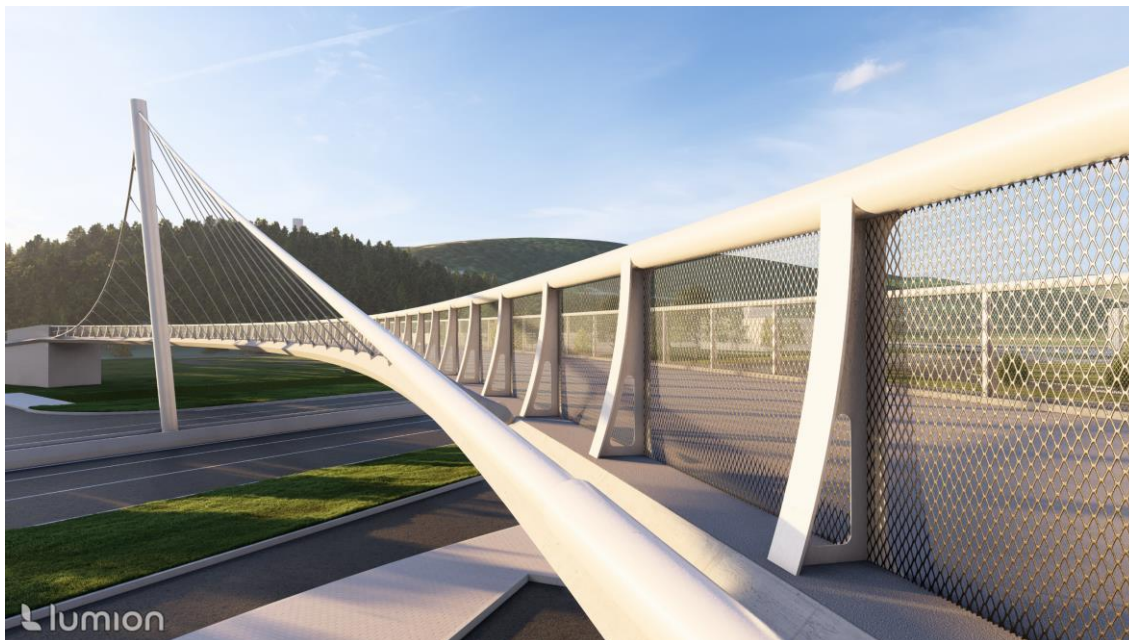
Obr. 71 Pohled na sloupky zábradlí a plechy kotvící závěsy
