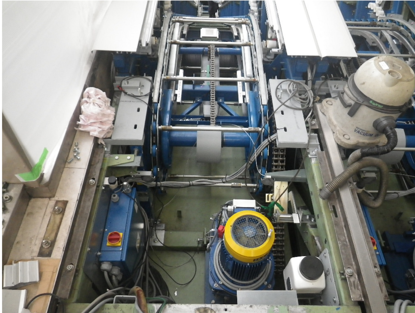
Obr. P11-4: Průběh modernizace, pohled do horní stanice. Usazený motor s převodovkou, mazání, elektrický rozvaděč, koleje, schodnicový řetěz, držáky hřebenové a nástupní desky.
