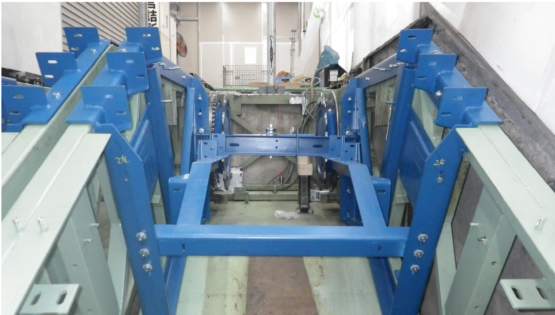
Obr. P11-3: Průběh modernizace, pohled na usazený adaptační rám a hlavní pohon v horní stanici.
