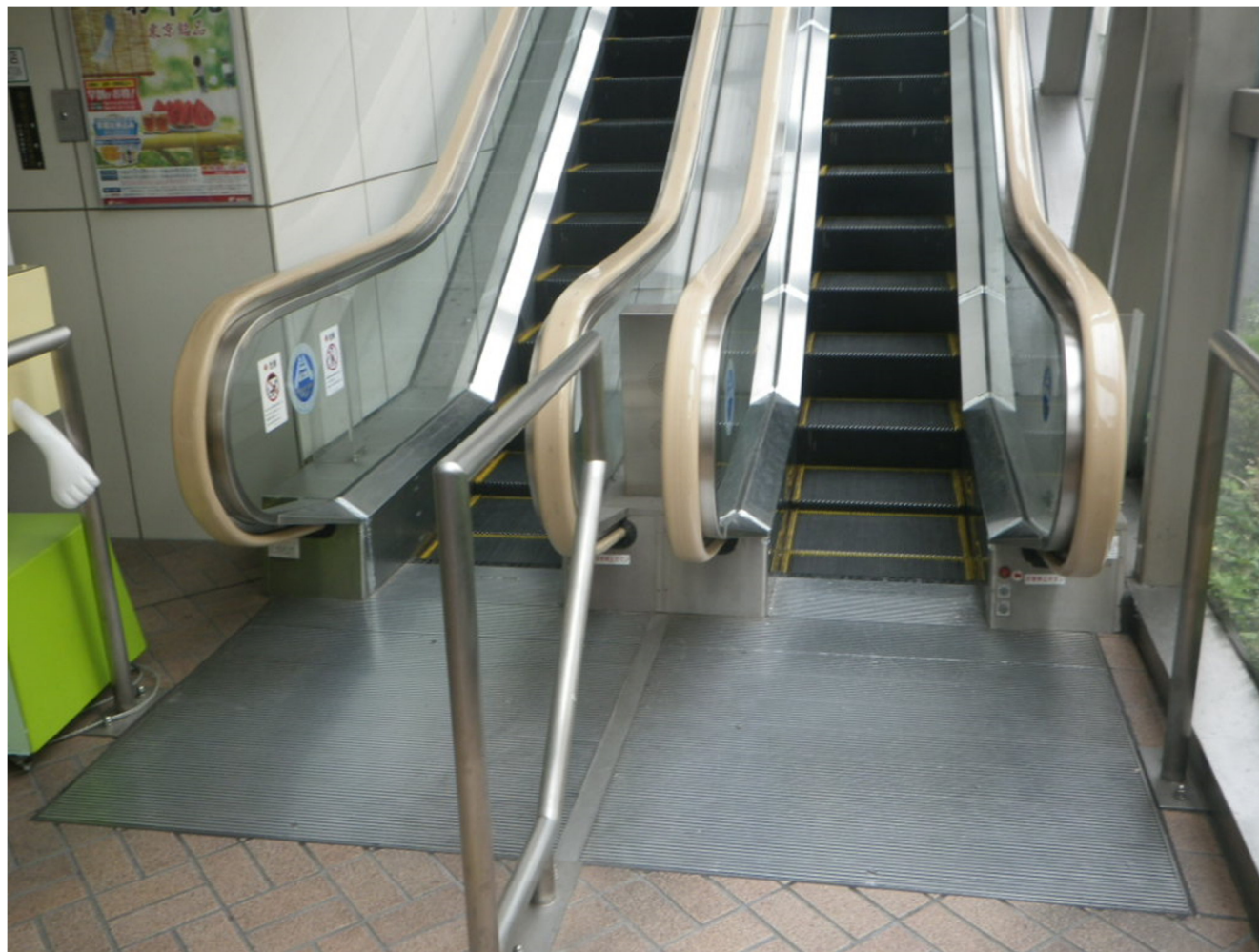
Obr. P11-1: Jednotky před modernizací.
