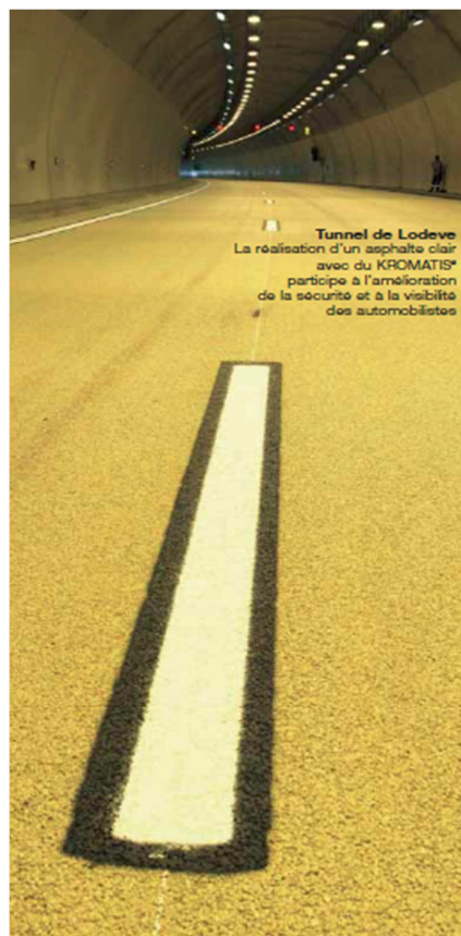
Obr. 2-10 Příklad barevné úpravy povrchu v tunelu Lodeve, Francie [21]
