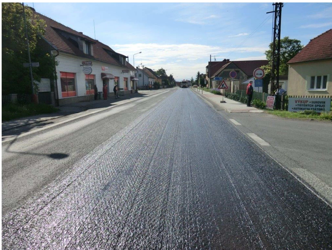
Obr. 2-8 Provádění spojovacího postřiku [38]
