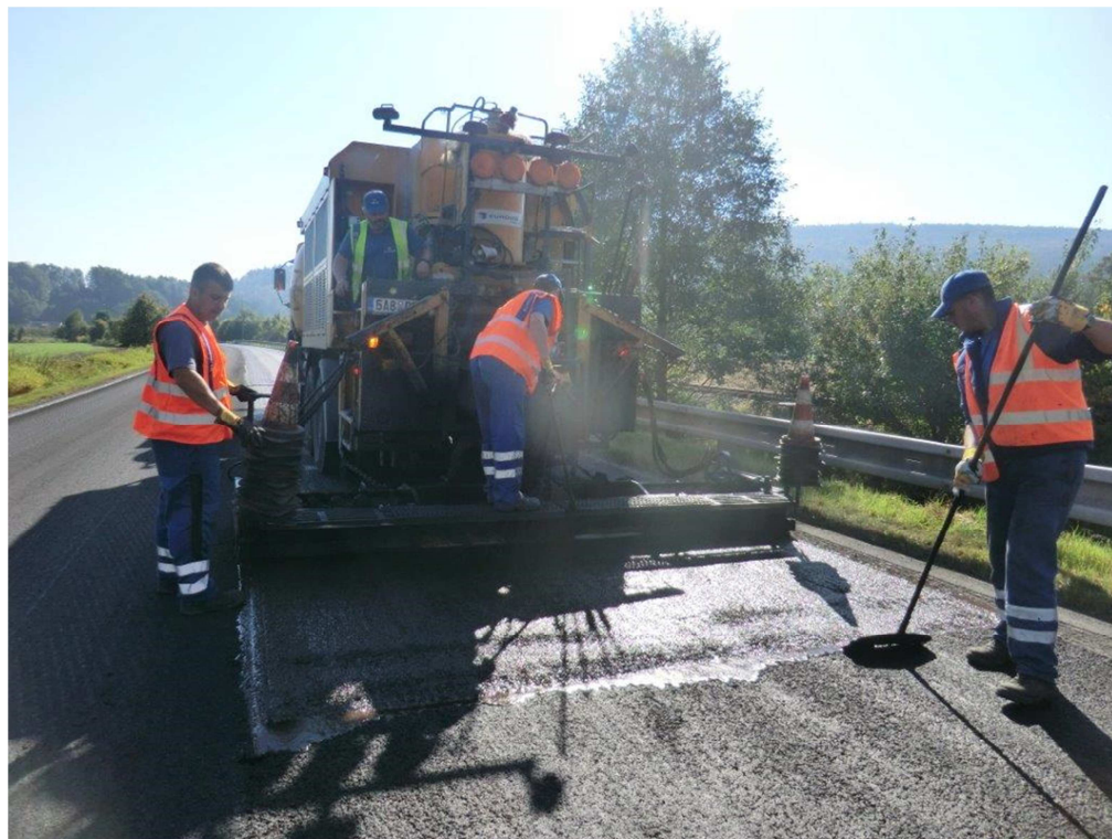
Obr. 2-18 Úprava příčné spáry po začátku pokládky [38]
