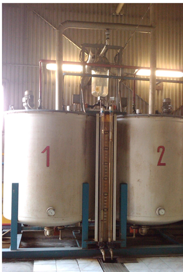
Obr. 2-5 Nádrže, kde dochází k promísení přísad a vody [38]
