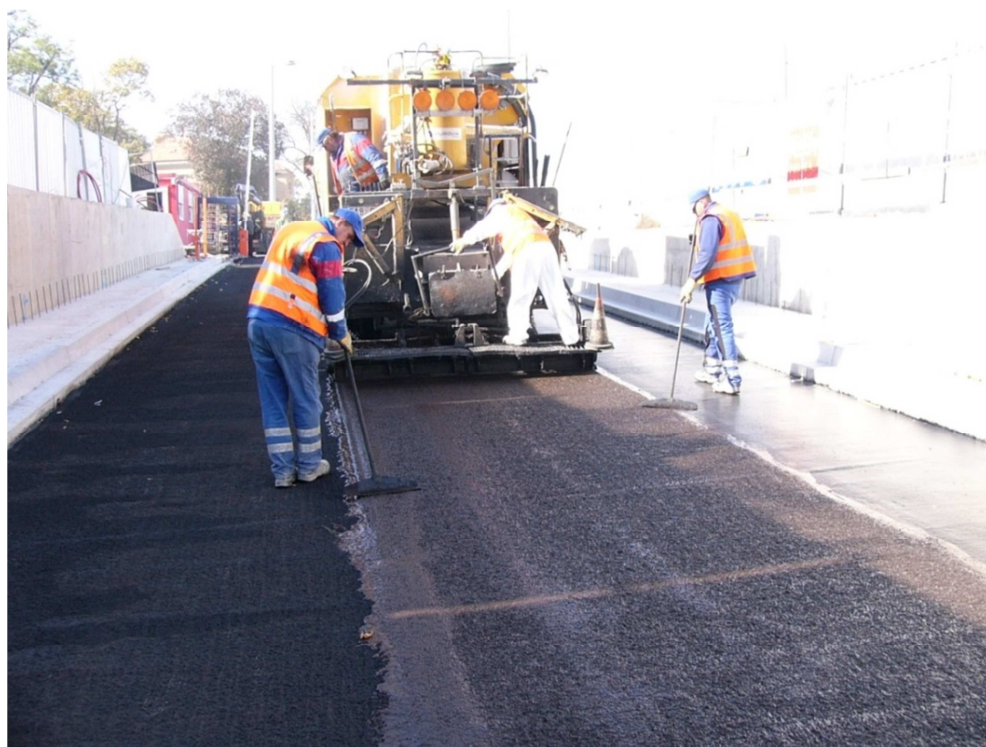
Obr. 2-22 Provádění pokládky EMK na jedné z vjezdových větví komplexu [38]
