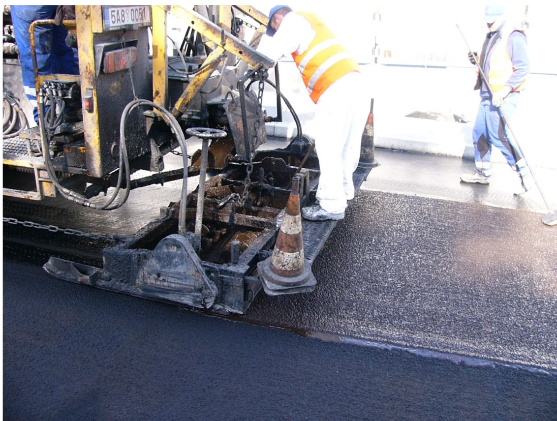
Obr. 2-9 Detail kladecího rámu během pokládky [38]
