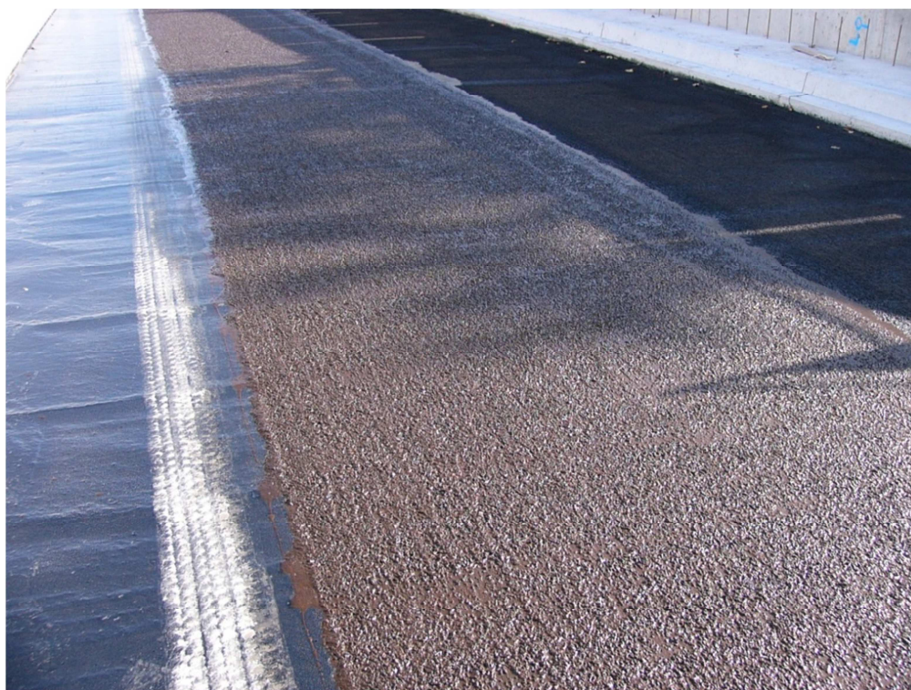
Obr. 2-23 Vjezdová větev tunelového komplexu blanka během provádění pokládky EMK [38]
