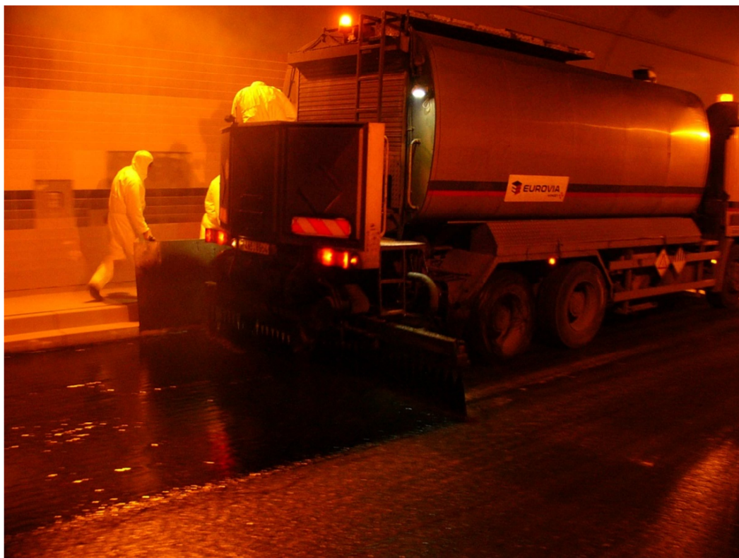
Obr. 2-21 Provádění postřiku asfaltové membrány v tubusu tunelu [38]
